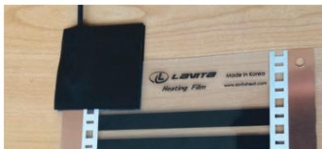
8 Фото после завершения подключения монтажных проводов.
